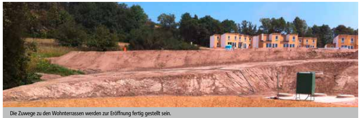
Die Zuwege zu den Wohnterrassen werden zur Eröffnung fertig gestellt sein.
